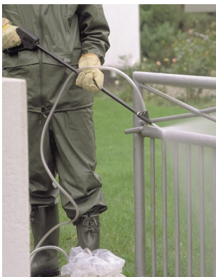
Sandblæsning af rust.
